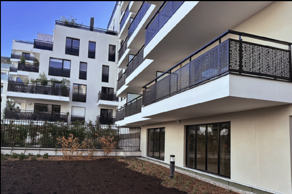
Garde-corps avec tôle poinçonnée
